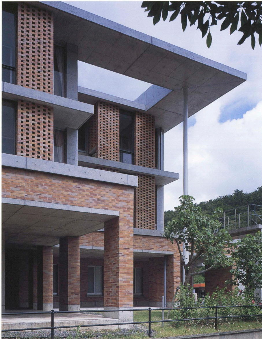
南東コーナー部 Corner of the southeast.
