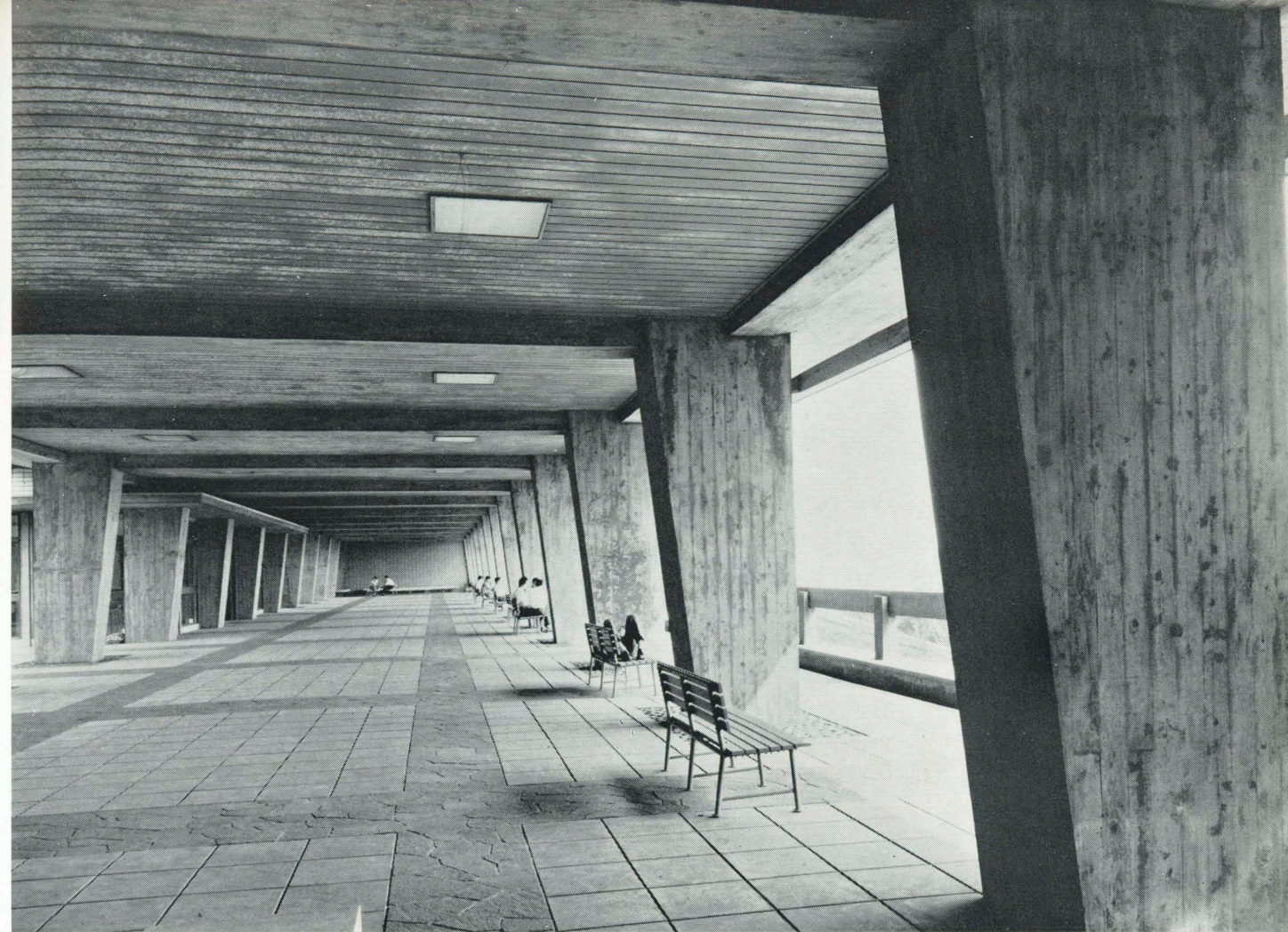
南校舎一階ピロティ
