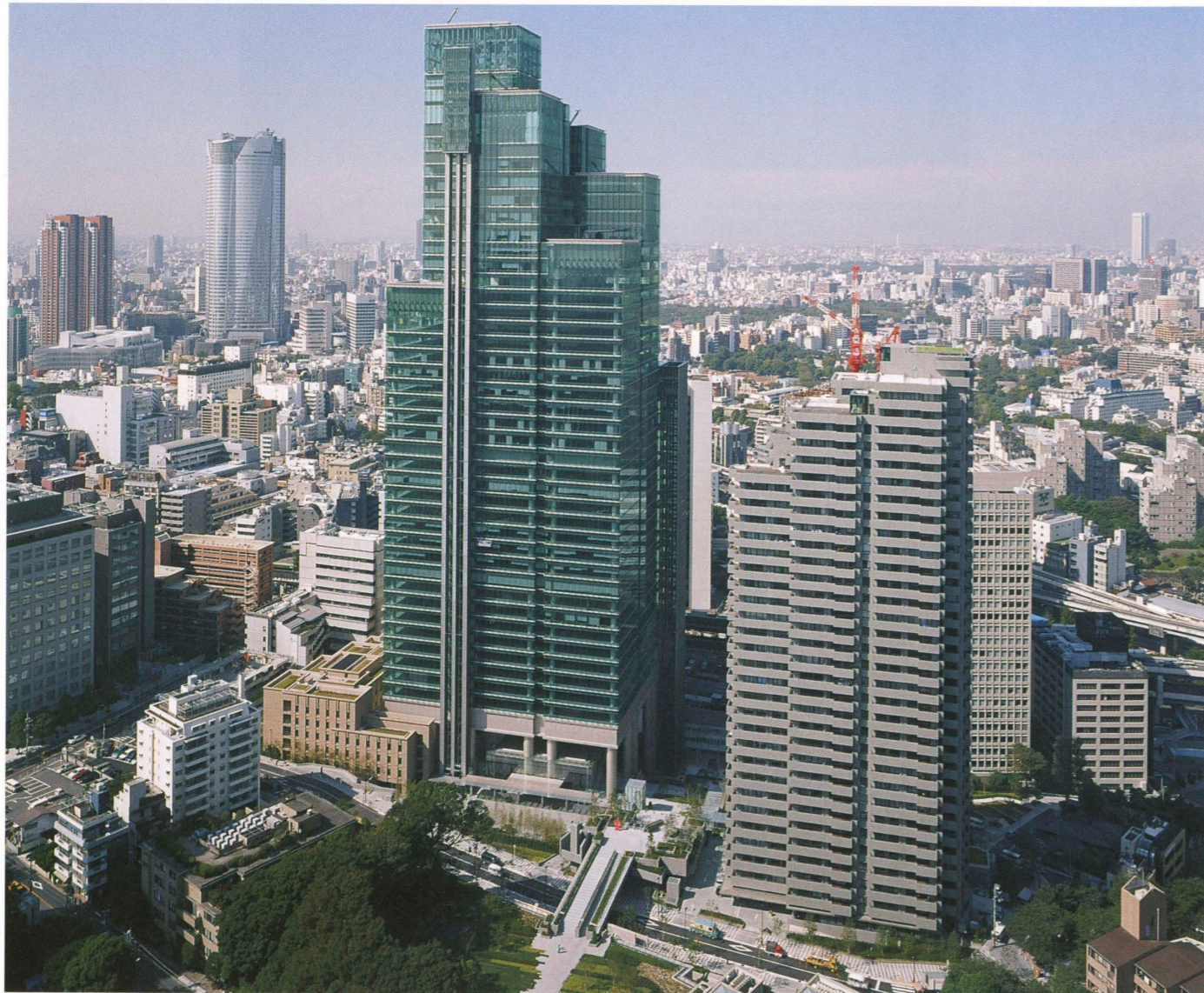
東側から見る 左が泉ガーデンタワー、右が泉ガーデンレジデンス View from the east side. The left is "Izumi Garden Tower" and the right is "Izumi Garden Residence".
