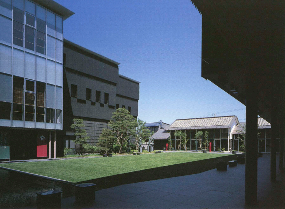
市民創造ひろば 奥は蔵を模したレストラン Public plaza. Restaurant wing molded on the Japanese storage in the background.
