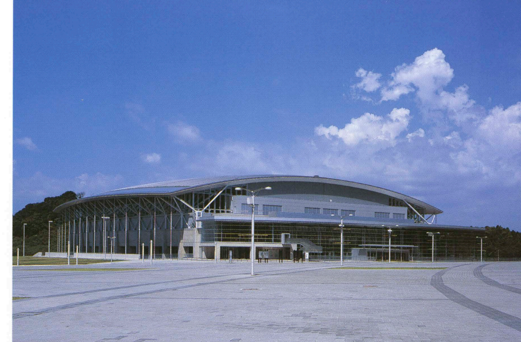
アリーナ全景 General view of the arena.
