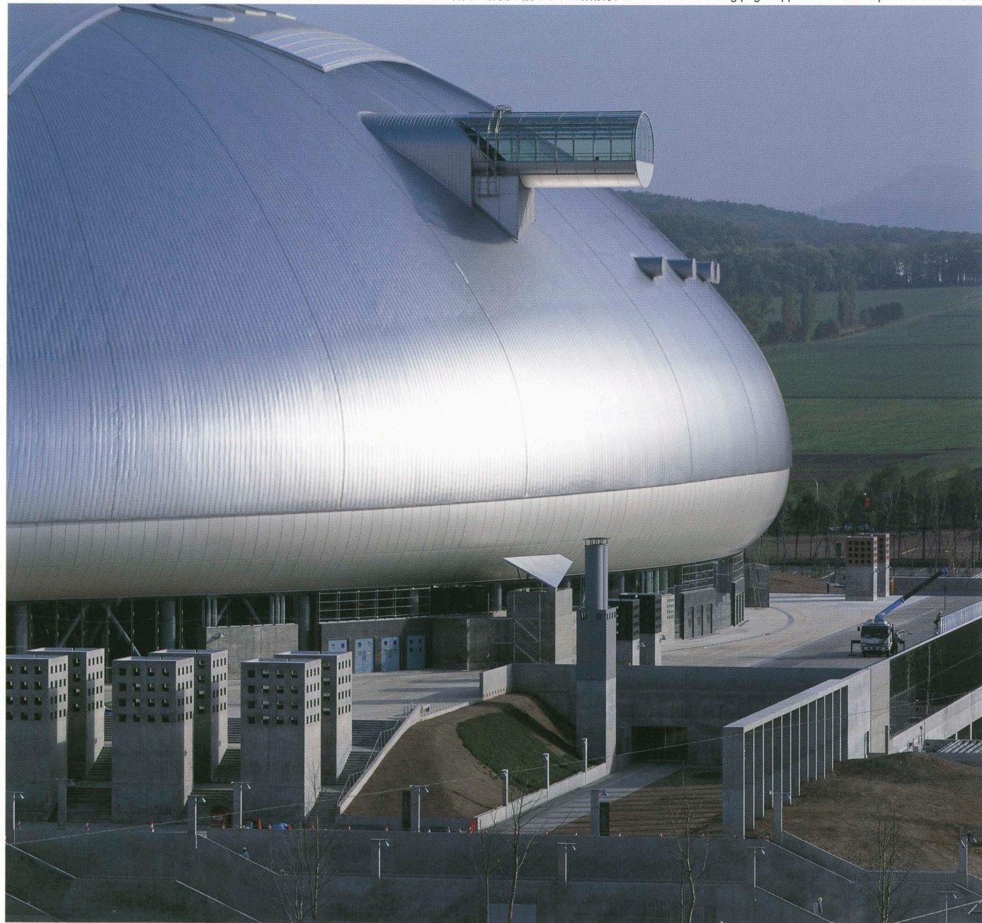
北側より見る ドーム屋根より筒状の展望台が突き出す View from the north. Cylindrical observatory protruding out of the dome.
