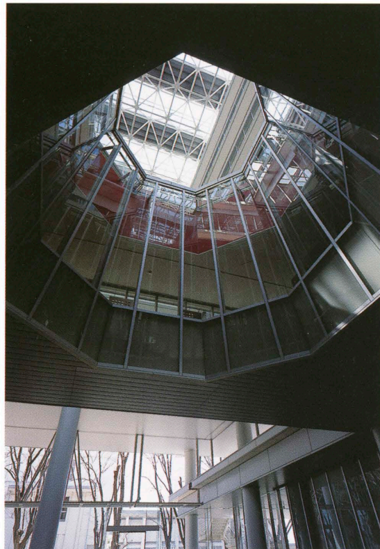
アトリウムからデータアーカイブの光筒を見上げる Upward view of the skylight.
