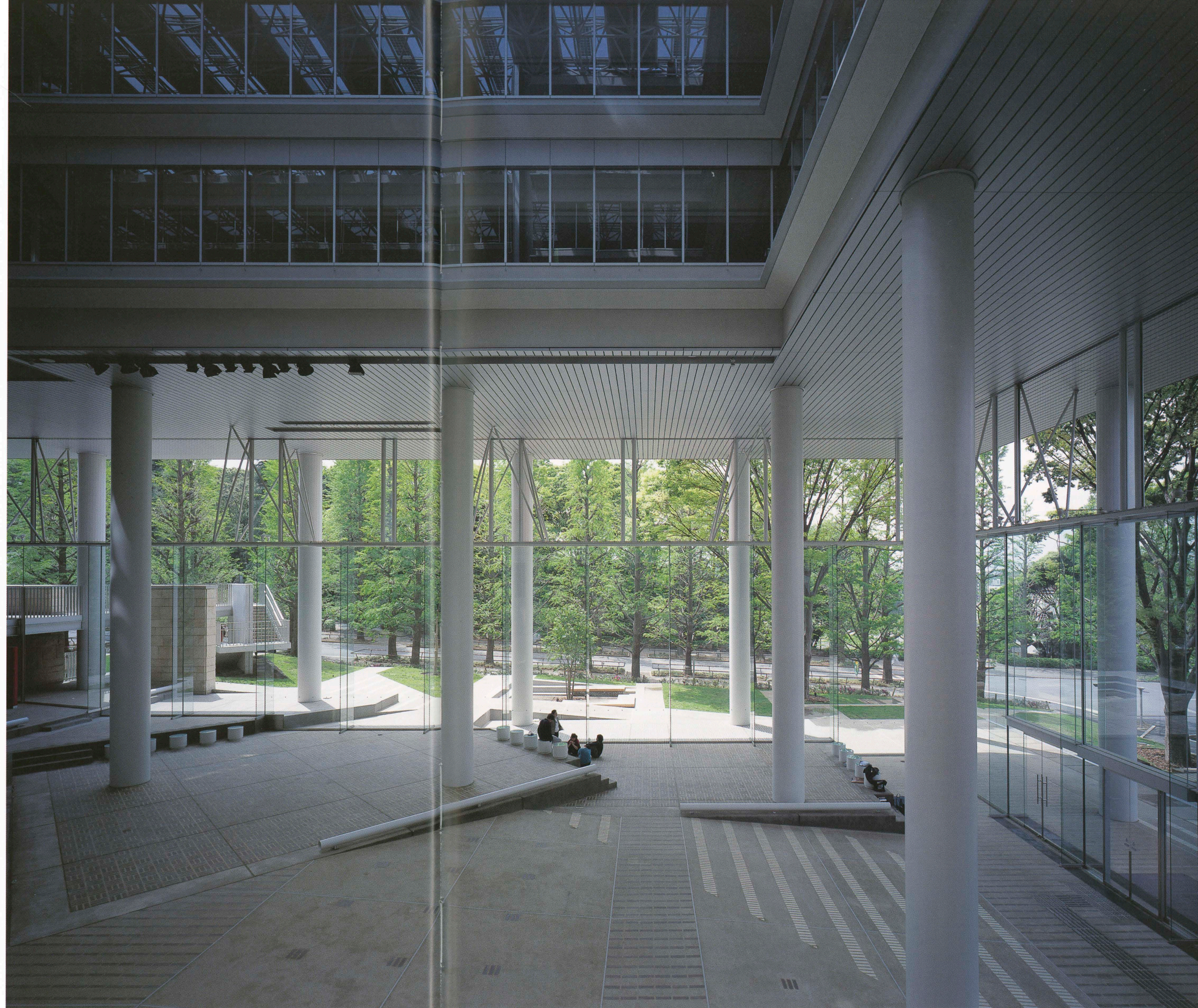
アトリウム ガラスカーテンウォールとCFT柱の採用で開放的な空間が可能となった The spaces of the atrium are open and integrated with the outdoor space.
