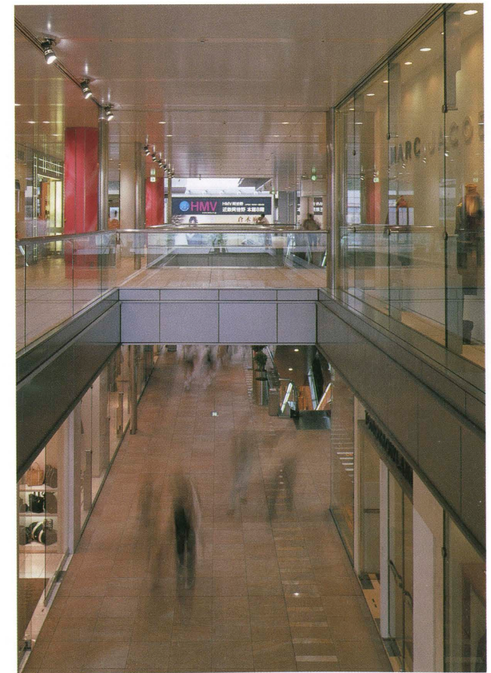
吹抜けの外部通路を見通す Open passageway.
