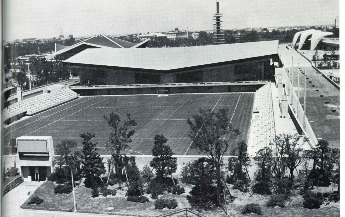
■ 南側より第一球技場及屋内球技場 No.1 play field & indoor valley court from south view
