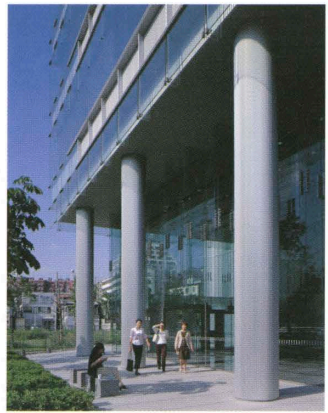
北玄関ホール西側外観 Northern entrance.
