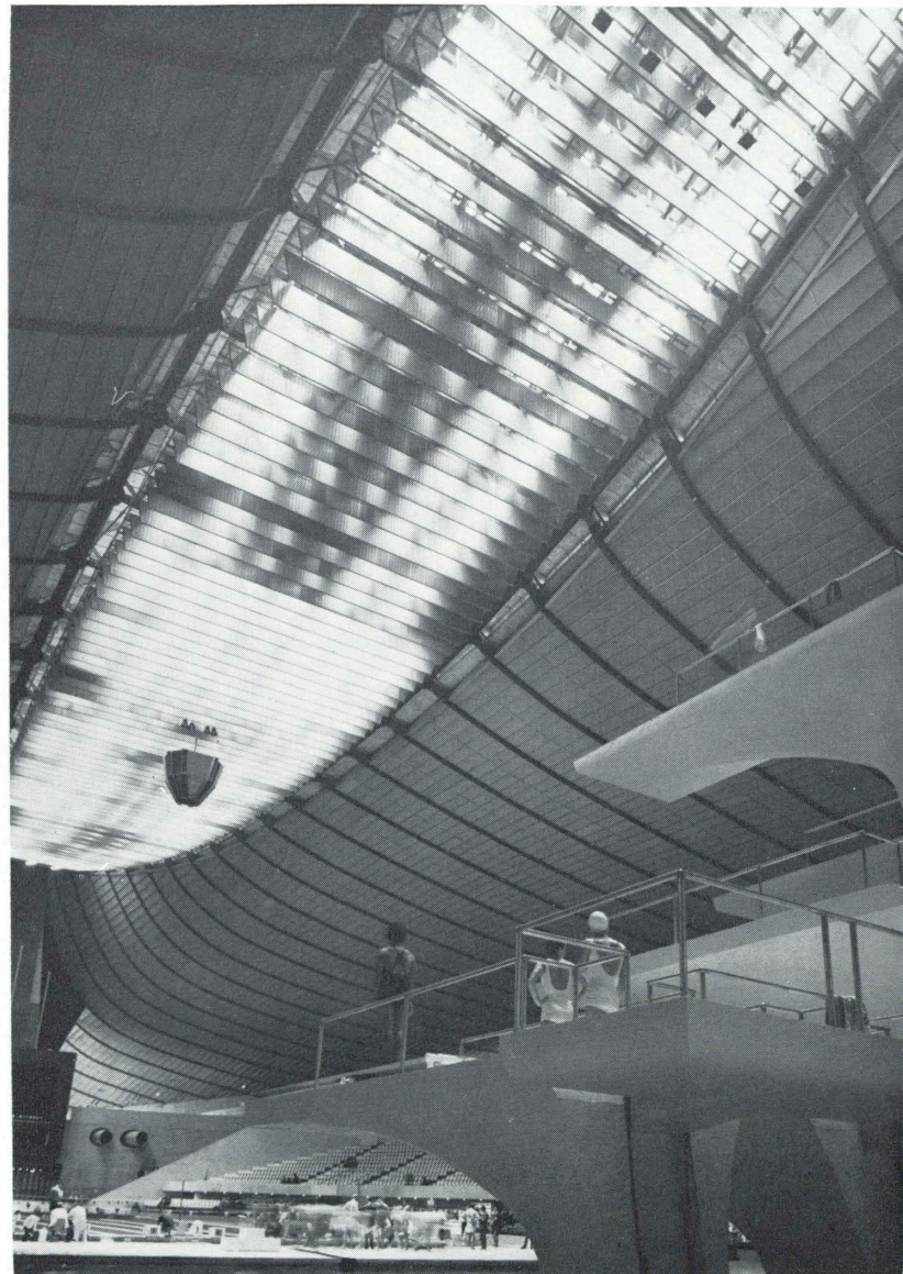
■ 越ヤネのアルミ垂直ハーバーと照明 Roof Detail with Master 中央に下がっているのが総合スピーカー Loudspeaker in the Center
