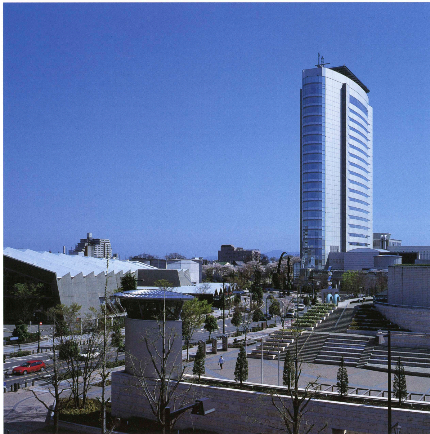
北側全景 右は同じ設計者による高崎シティギャラリー 左はアントニン・レーモンドによる群馬音楽センター General view from the north. Gunma Music Center (left) designed by Antonin Raymond.
