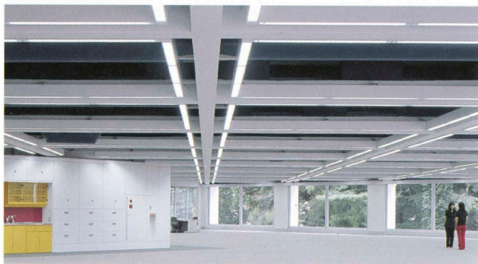
事務室 Office floor.
