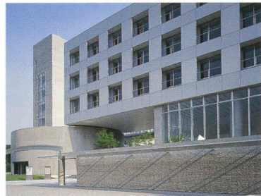
エントランスプラザから管理棟を見る Administration building.
