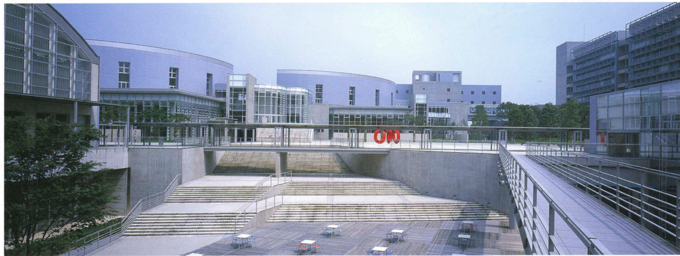
サンクンガーデン越しに北側を見通す 左よりアリーナ、階段教室棟、管理棟、研修棟 View over the sunken garden from the south.
