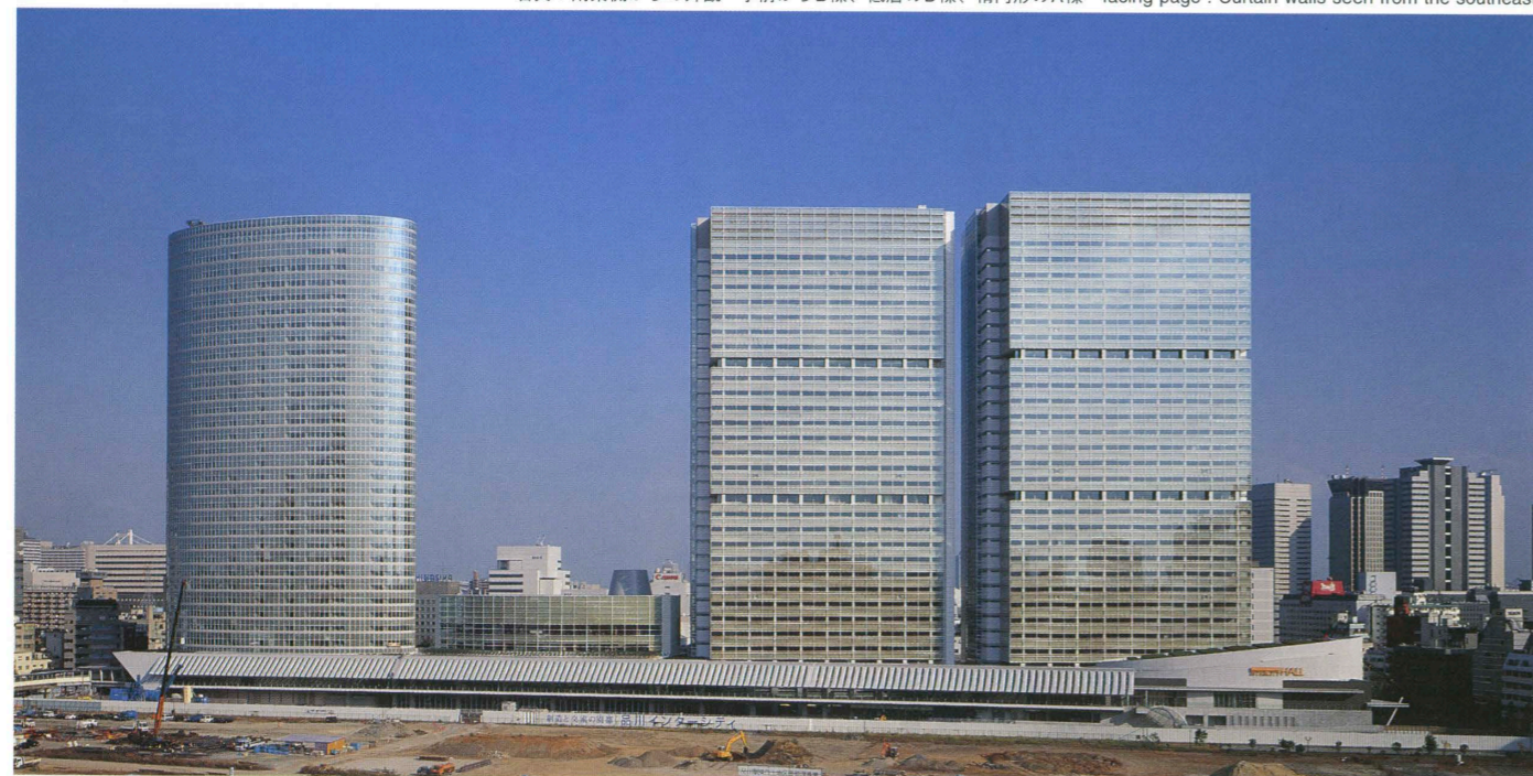
品川駅側（西側）からの全景 General view from the west.
