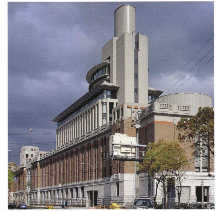
西より北側立面を見る View from the west.
