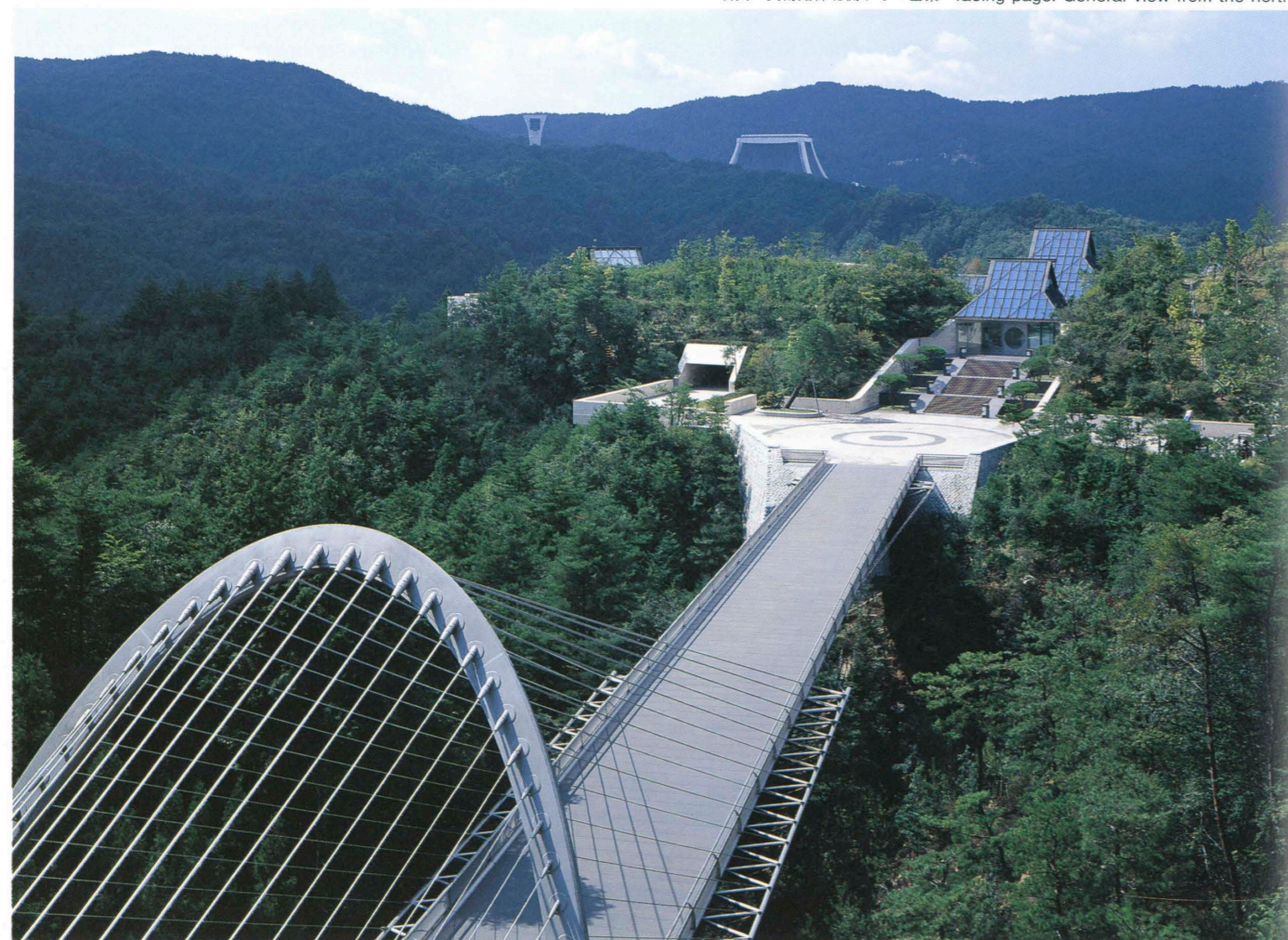
トンネル側からの眺望 General view from the tunnel side.
