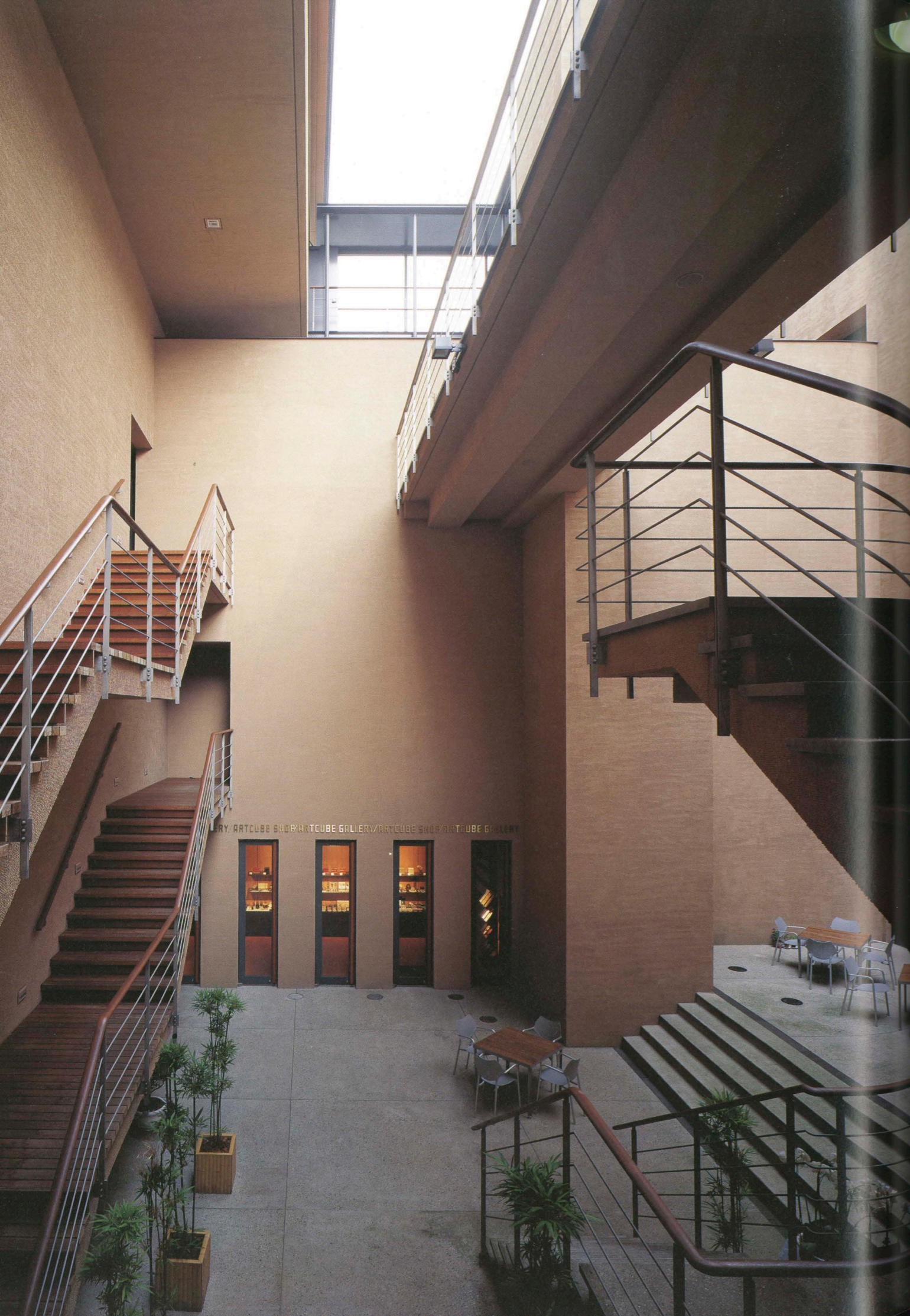
左頁：地下1階レベルからサンクンガーデンを見る facing page: Sunken garden seen from the first basement level.
