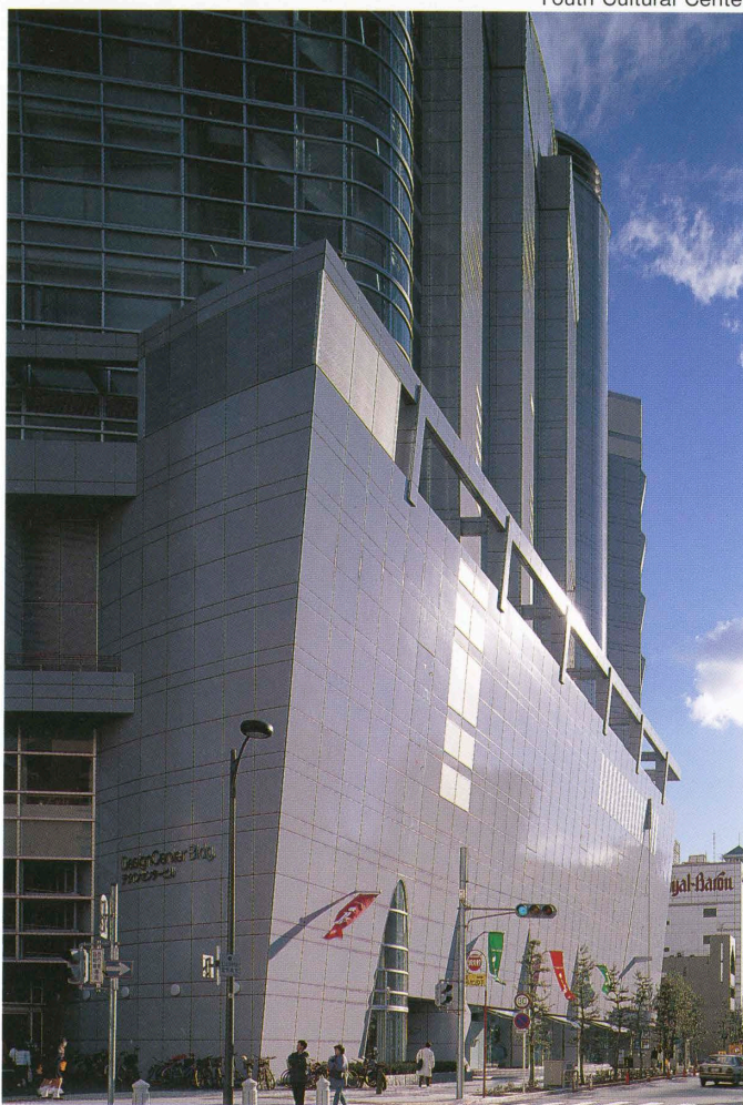
デザインセンタービルの北西コーナー足元 View from the northwest.
