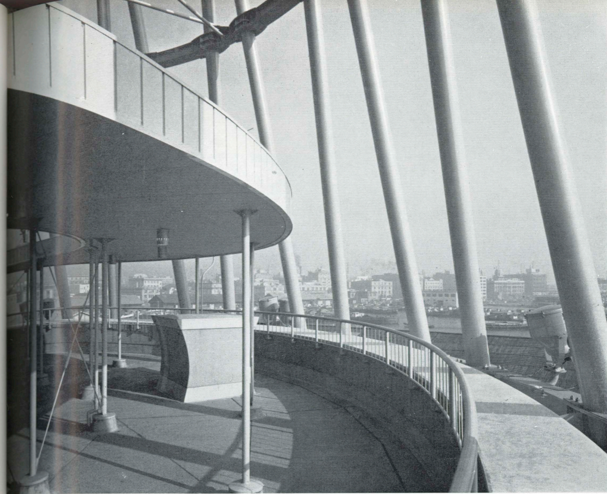
■ 下部建物屋上休憩所 rest place-Base Bldg. Roof floor
