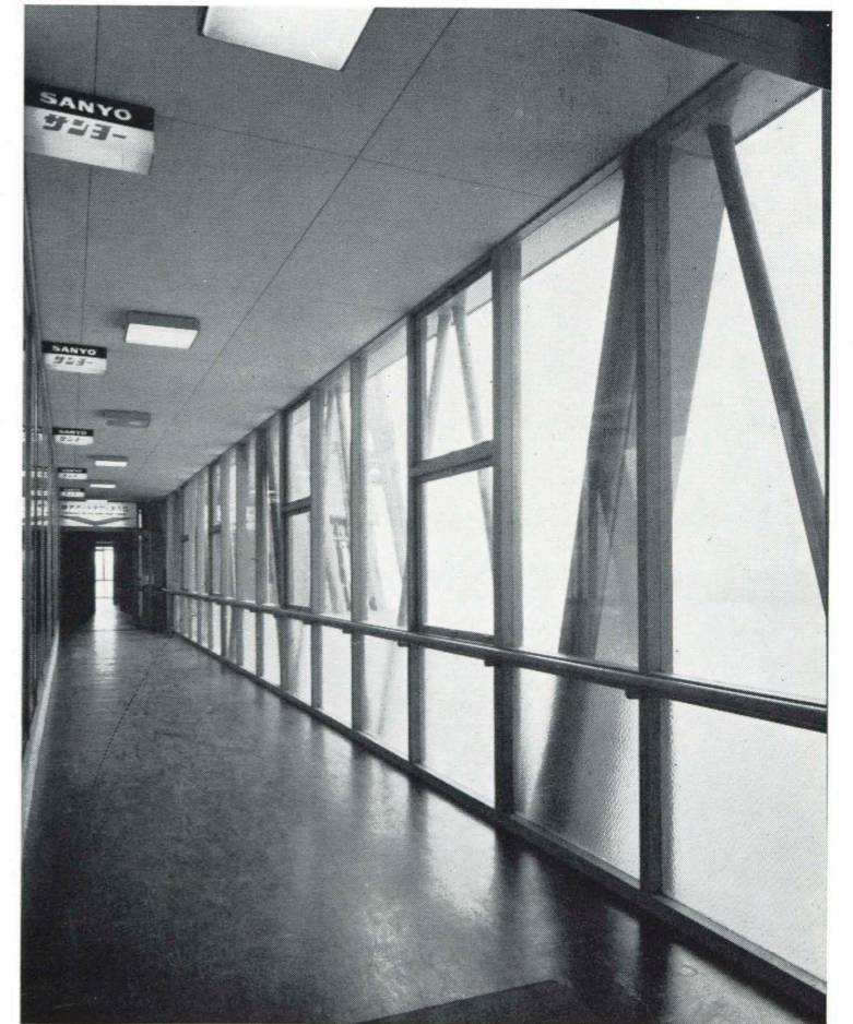
■ 博物館への連絡ブリッジ内部 interior-bridge to Museum
