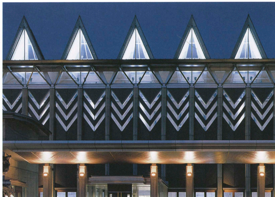
アトリウム棟外観 Night view of the Atrium.
