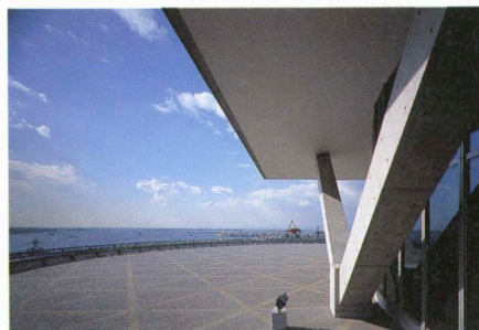
最上階のルーフトラスから海を見る View from the roof terrace.
