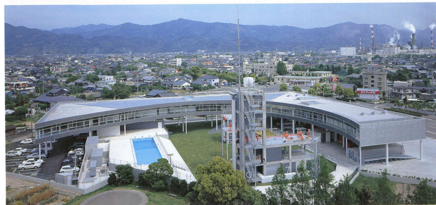
右頁：6 mの高さにもち上げられた開放的なピロティ right: 6-meter high open pilotis.
