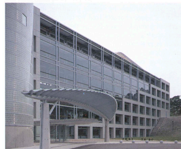
北側エントランス Entrance on the north.
