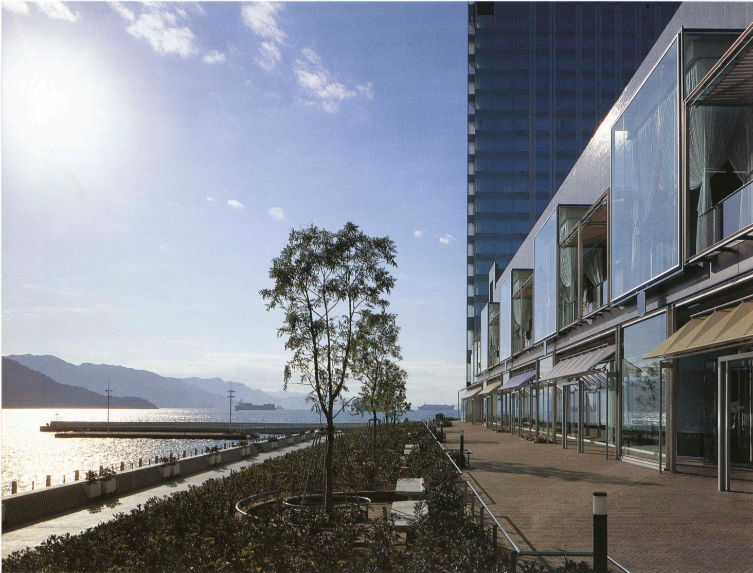
瀬戸内海に面した大宴会場東側外観 Exterior of the main banquet hall facing the Seto Inland Sea. 右：アプローチからの全景 rihgt : General view from the approach.
