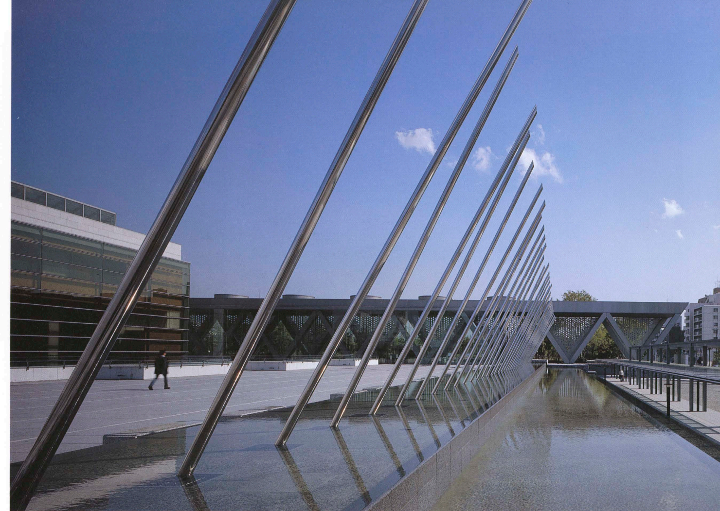
パブリックプラザの池を通して見る Entrance wing seen over the pond in the public plaza.
