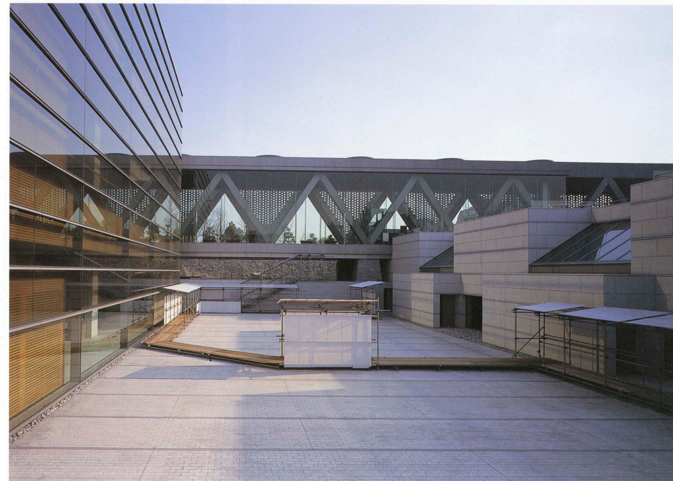
地下2階のサンクンガーデン Sunken garden on the second basement level.
