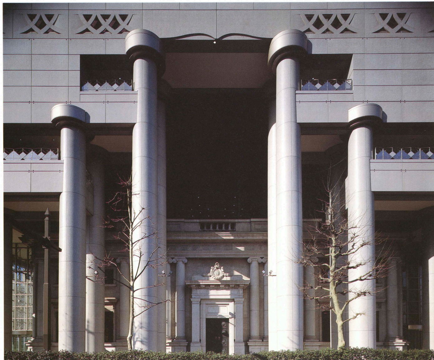
東側ファサード、保存した建物の一部が見える Facade on the east.／右：北側から国道沿いの全景 right: View from the north.
