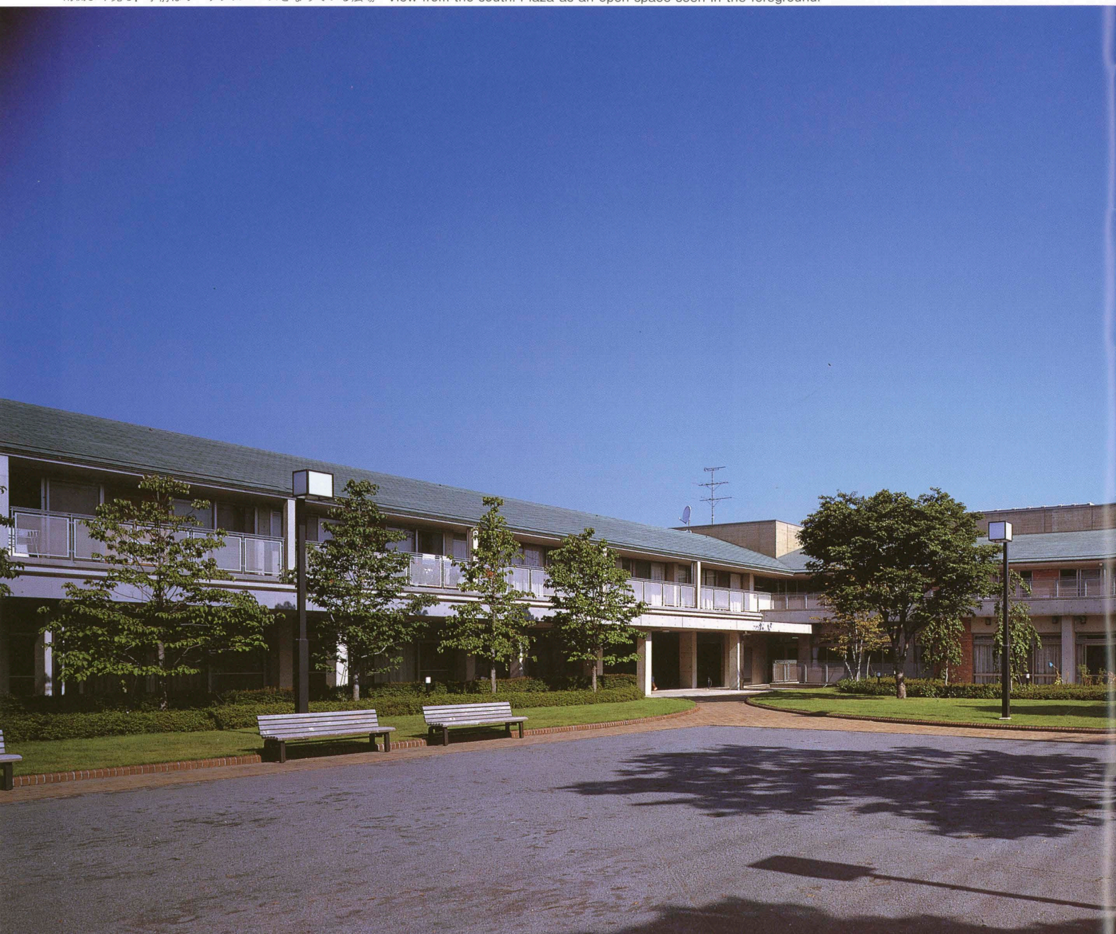
南側より見る。手前はオープンスペースとなっている広場 View from the south. Plaza as an open space seen in the foreground.
