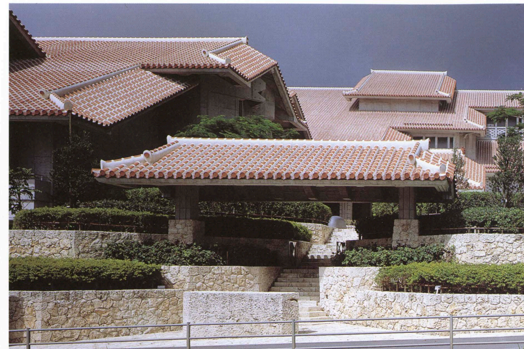
東側のメインゲート Main gate on the east.
