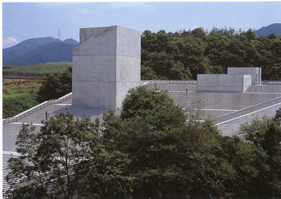
散策路から展望広場の大階段の遠望 Distant view of the staircase plaza from the promenade.
