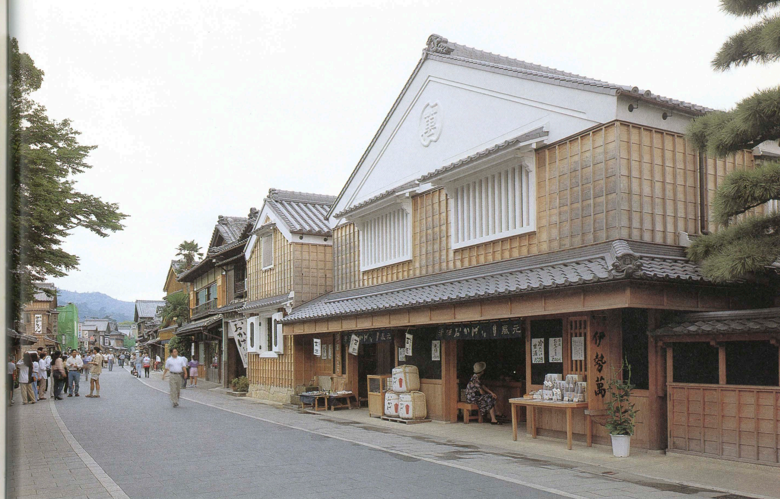
中央通りから北側方面を見る Viewing toward the north from the central street.
