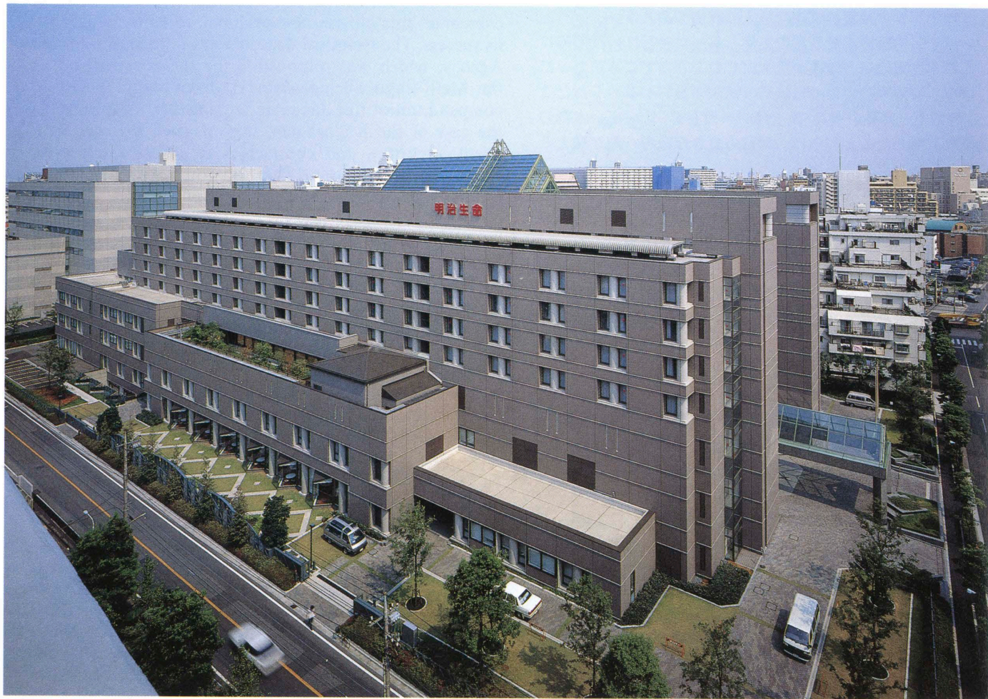
全景 General view.／右：エントランス回り right: Entrance.
