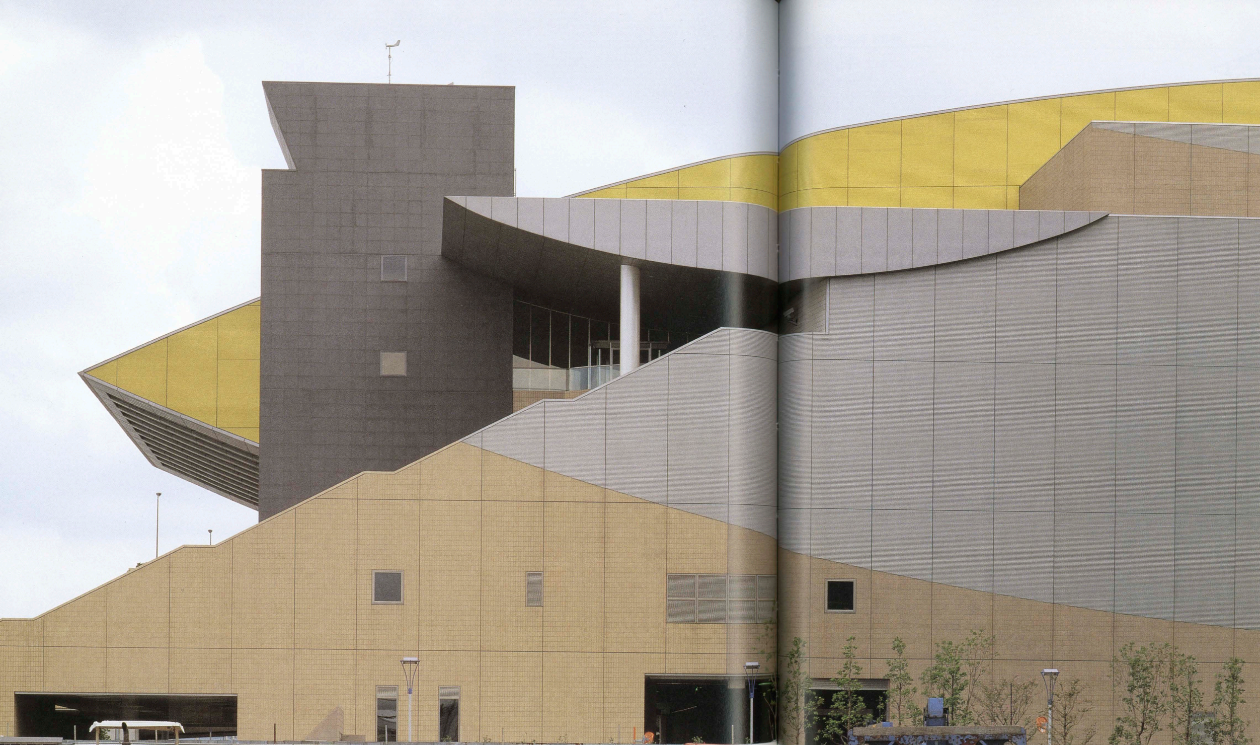
北側壁面および4階へ続く階段を見る Detail of the exterior wall on the north.
