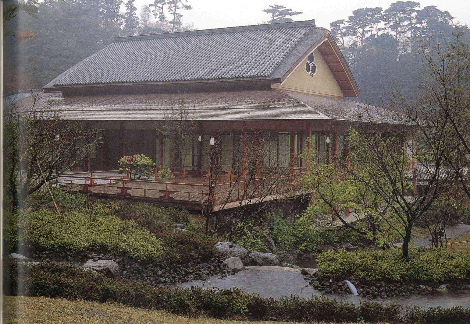
南東より広間棟を見る。大和葺風のむくりのついた大屋根 Detached wing for the main banquet seen from the southeast.
