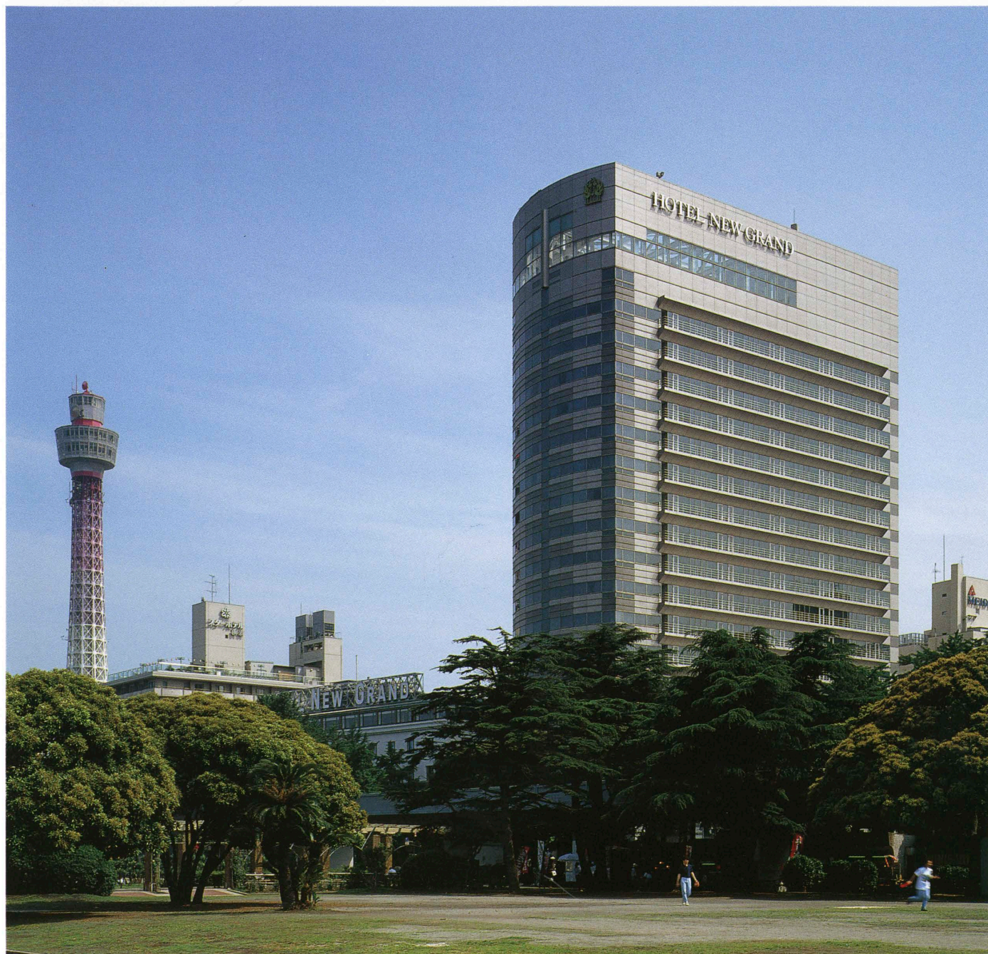
山下公園から見た全景 高層の新館と低層の本館からなる General view from Yamashita Park.
