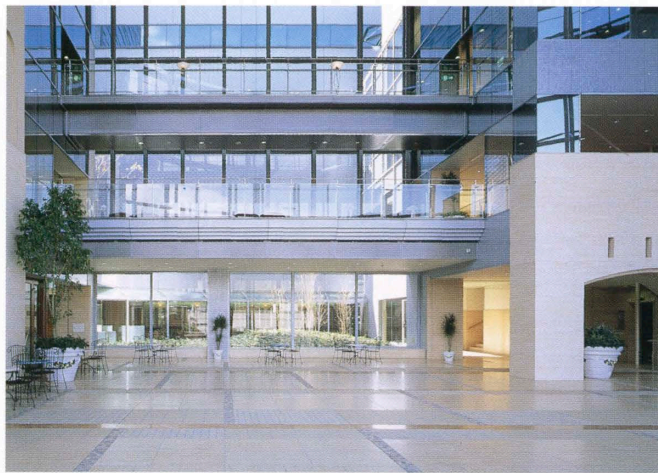
アトリウムからブリッジと西館方向を見る View of the bridge from the atrium.
