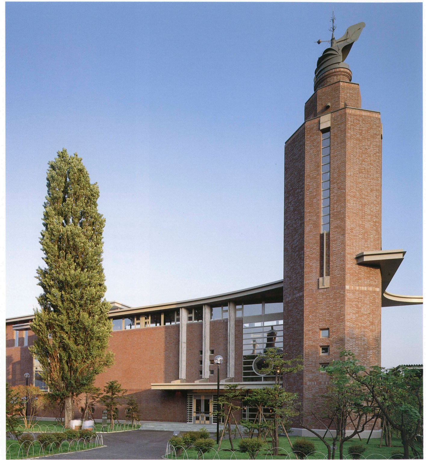
ポブラ館北側外観 North side view.
