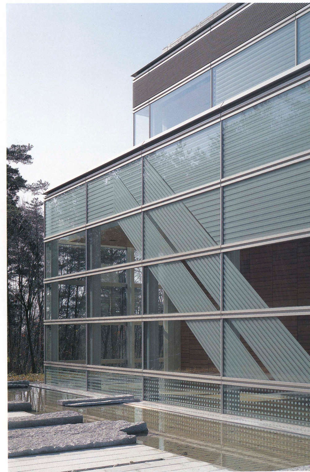
美術館のファサードの詳細 内側のガラスにエッチングが施されている Detail of the facade of the museum. Pattern-etched glass fixed in the inner glass.
