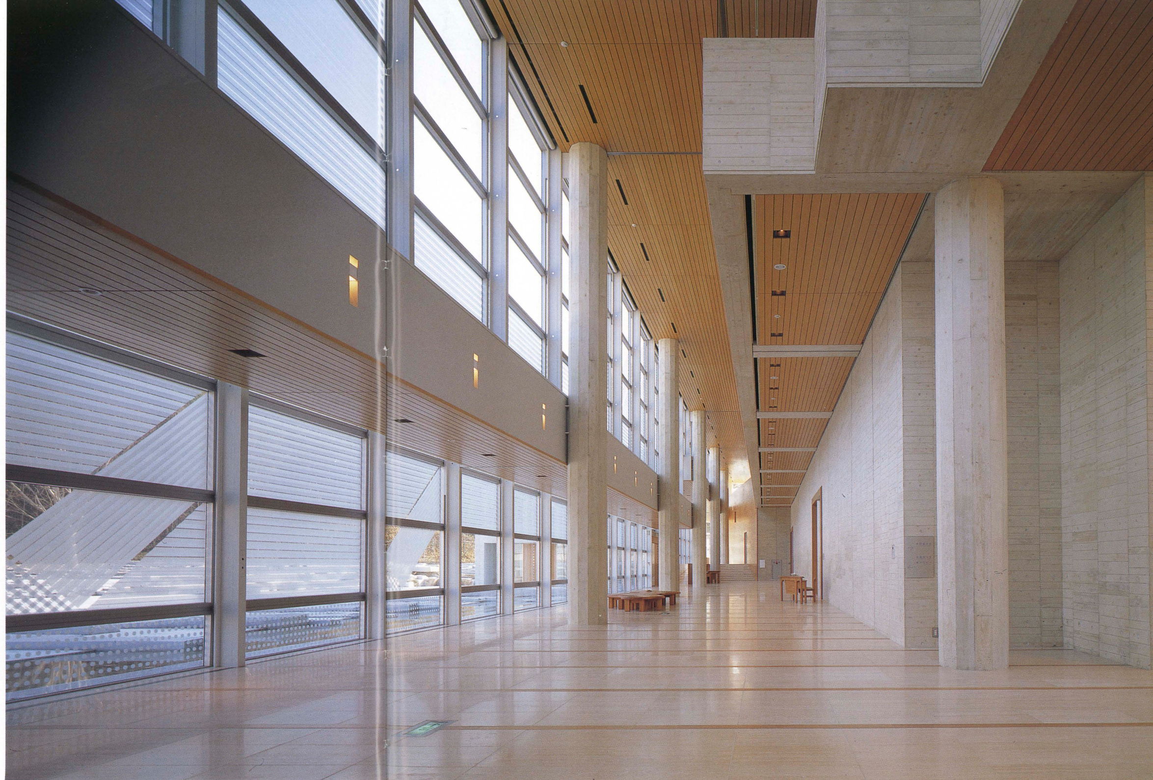
展示ロビー 壁のホワイトコンクリート打放しはガラスのエッチングに呼応している Exhibition lobby. Exposed white-concrete wall in response to the pattern-etched glass.
