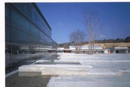
石の広場の南端より見る View from the south end of the stone plaza.
