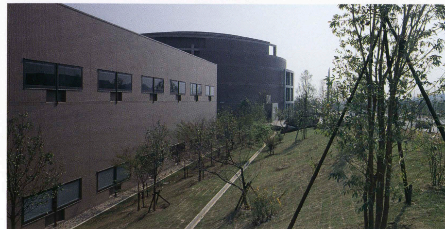
通りに面したスーパーラボ棟 Super-laboratory wing faced to the street.
