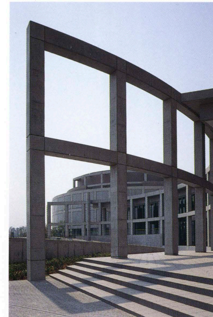
円弧状のフレーム Circular concrete frame.
