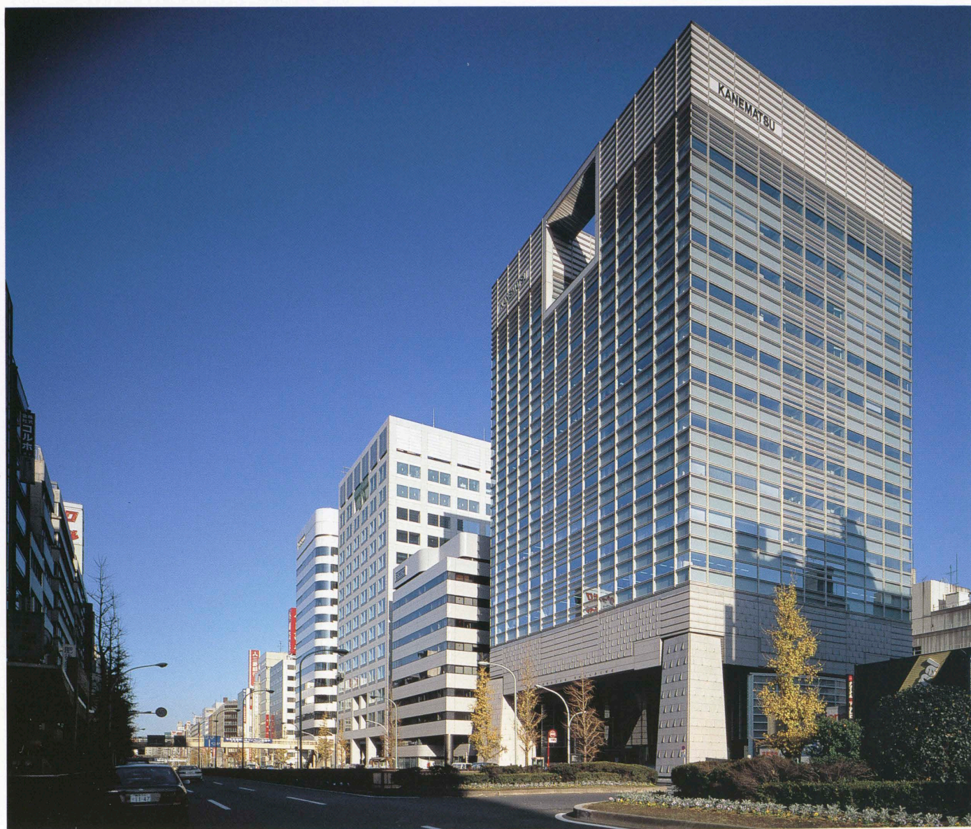
前面の通りから見る 4本の柱で人工地盤を支えている General view over the street. Elevated-structural floor supported by the four columns.
