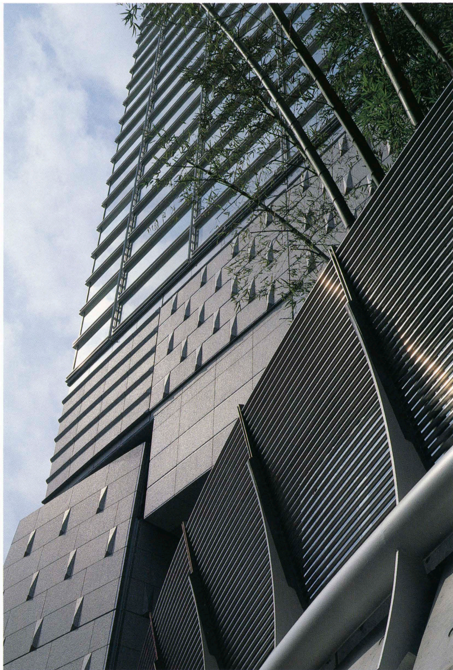
東側ファサード見上げ Upward view of the east facade.
