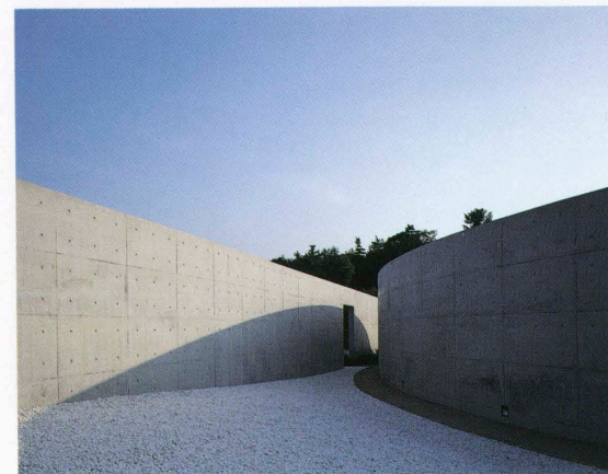
アプローチ見返し Approach to the stairway.
