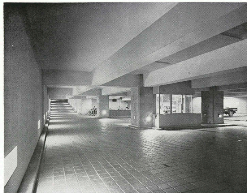
■ 地下二階ガレージ Garage, 2nd basement
