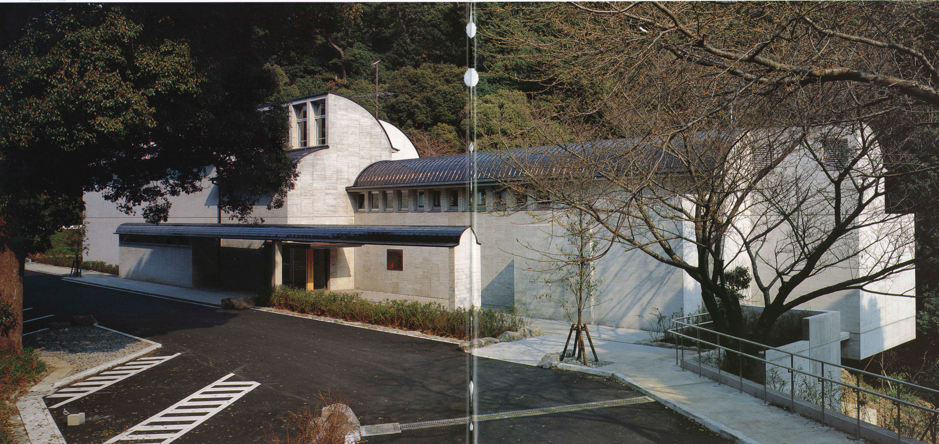
東側からの外観 View from the east.
