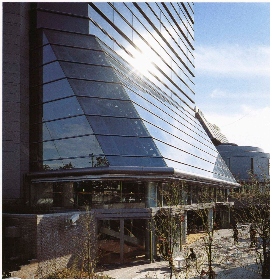
地下1階レベルのサンクンガーデン Sunken garden on the basement floor.
