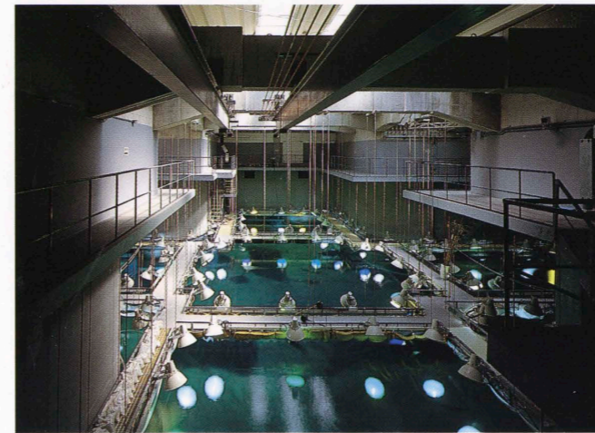
「海遊館」水槽上部のメンテナンスエリア Maintenance area above the exhibition tank.
