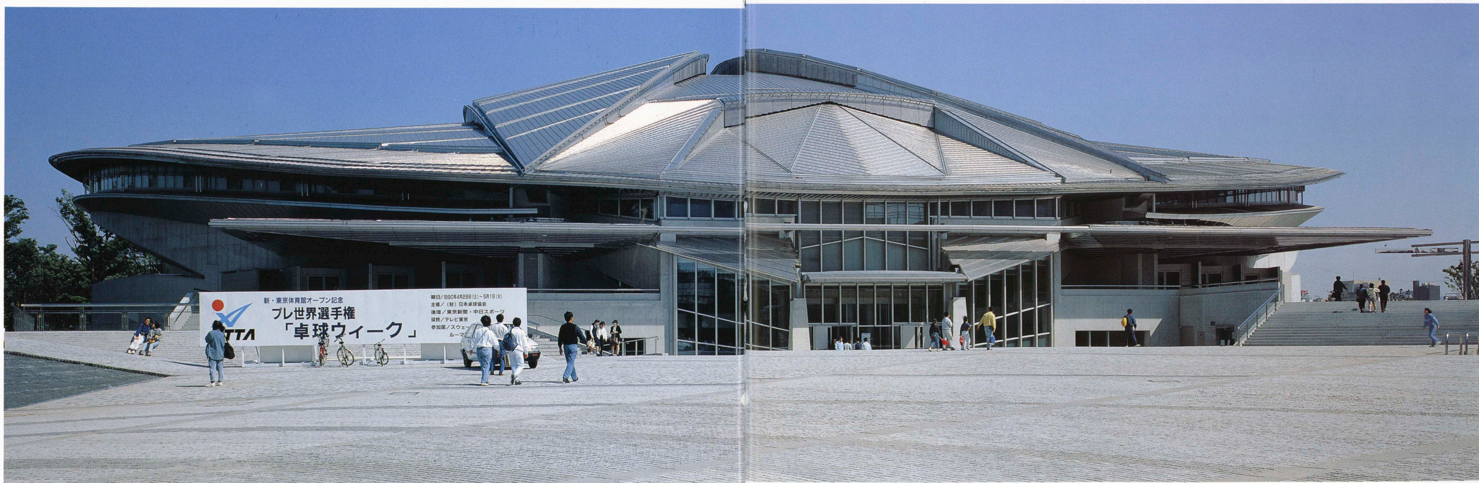
西側立面 View of the west side.
