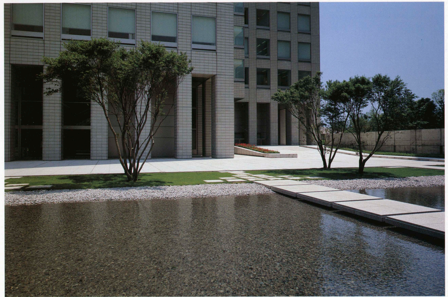
オフィス棟足元回り Lower part of the office tower.
