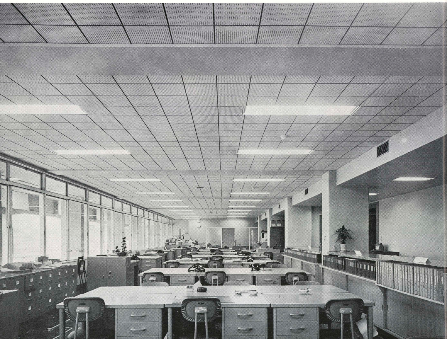
■ 事務室 Office room
