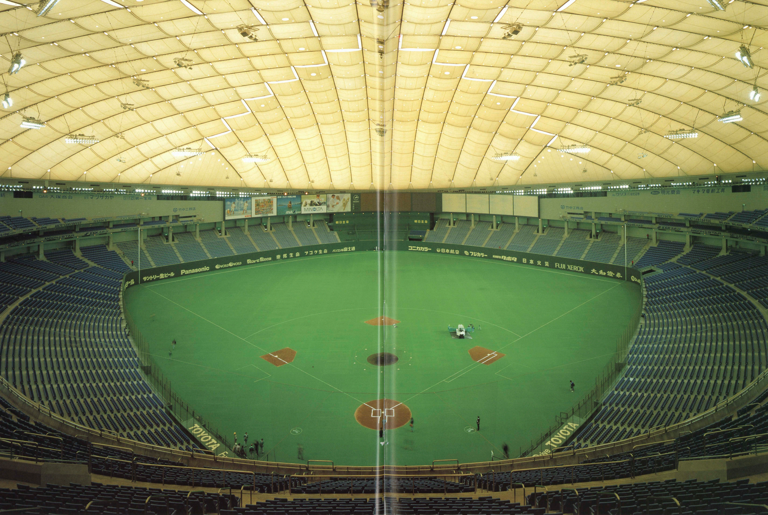
▲アリーナ Pneumatic-dome-covered arena.
