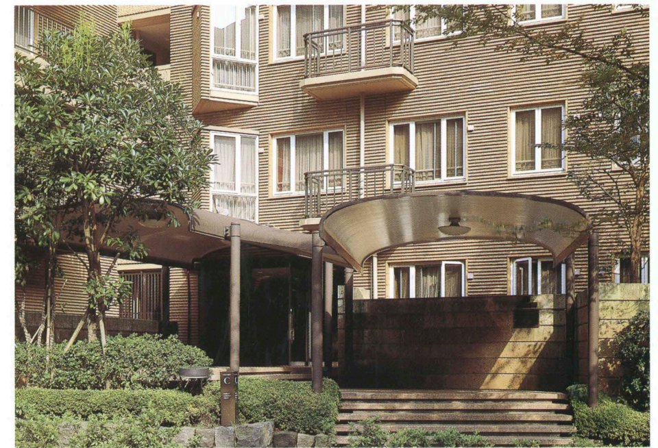
イーストヒル(C棟)玄関 Entrance to East Hill.
