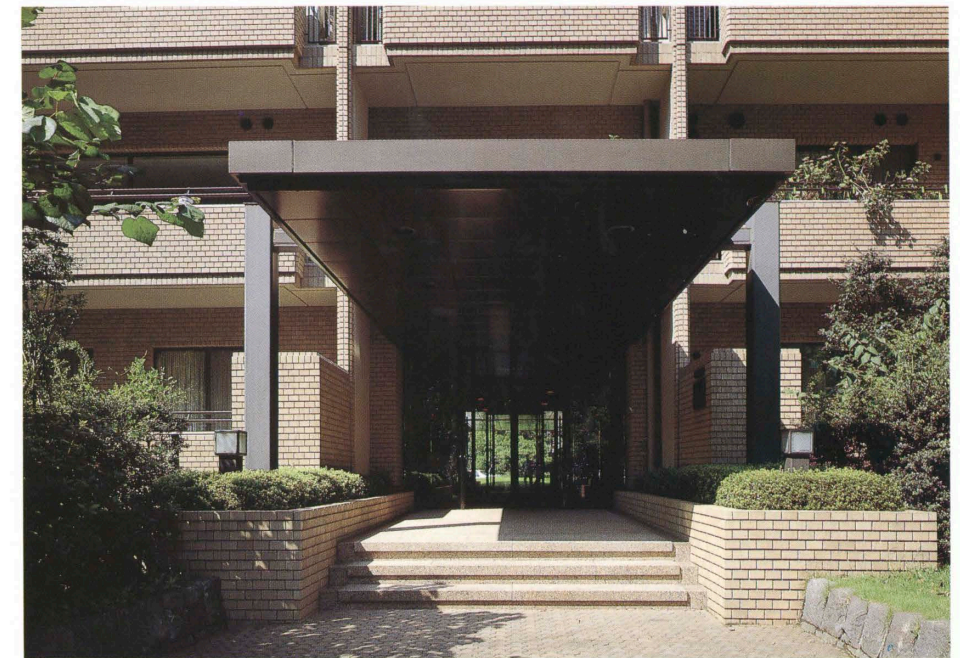
ノースヒル(M棟)玄関 Entrance to North Hill.
